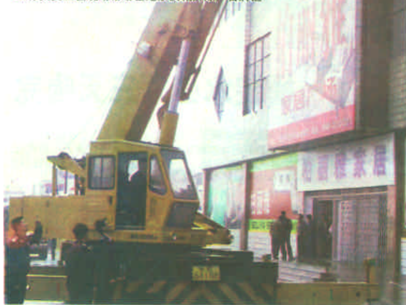
工作人员正在现场帮助世纪家具城拆除广告牌
